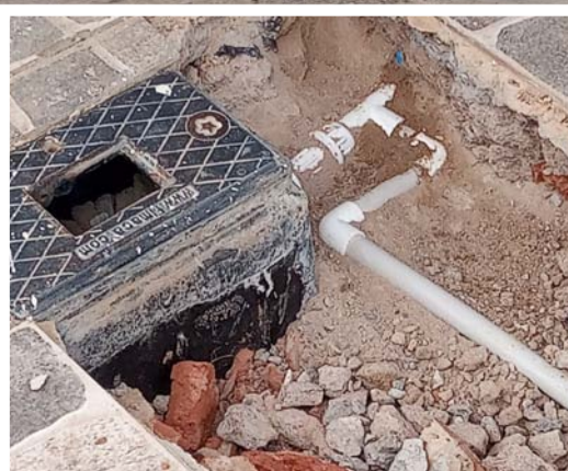
Así se hallaron las acometidas ilegales en el predio intervenido en Riohacha.
