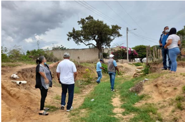
La temporada de lluvias los mantienen alarmados ya que la calle 59 ha desaparecido por el desagüe.
