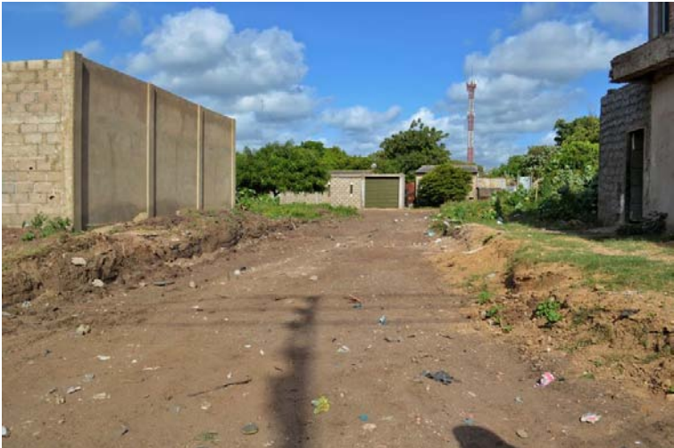
Las obras consistieron en remover todo tipo de material que en época de invierno genera las inundaciones.
