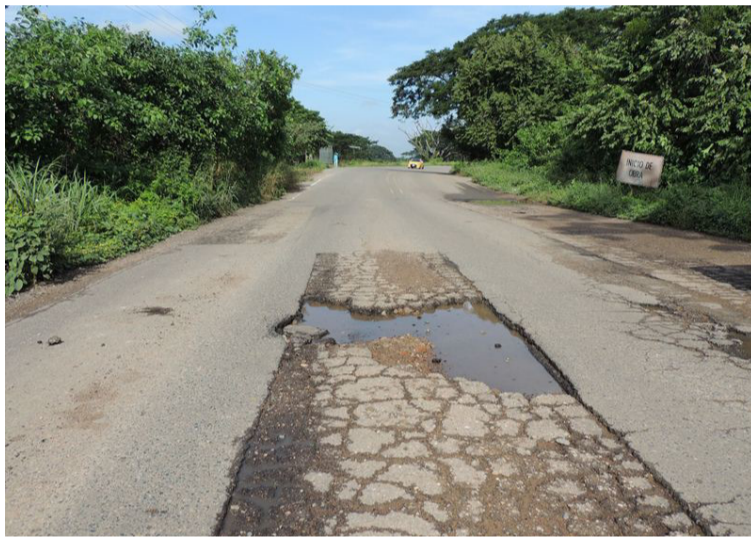
La pavimentación de la vía La Florida-Cuestecita es de las obras más esperadas por los habitantes guajiros.
