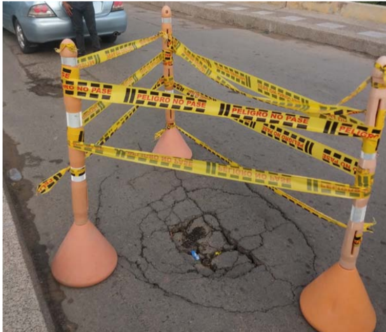
El contrato para el inicio de trabajos en el puente del Riíto en la ciudad de Riohacha ya fue adjudicado.
