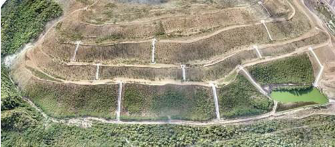
Estas estructuras reducen y controlan la velocidad y fuerza del agua en su recorrido.
