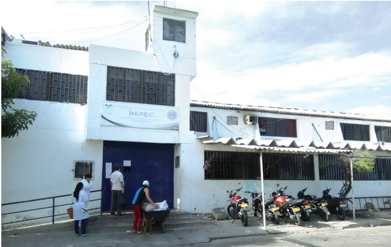
Internos, guardia y personal administrativo de la Cárcel de Riohacha están en riesgo en caso de generarse incendio.
