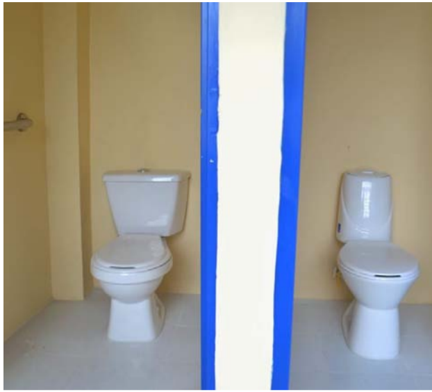
Se adecuó una batería sanitaria dotada con 6 equipos sanitarios, tres para niños y tres para niñas, lavamanos, tanque elevado y posa séptica.
