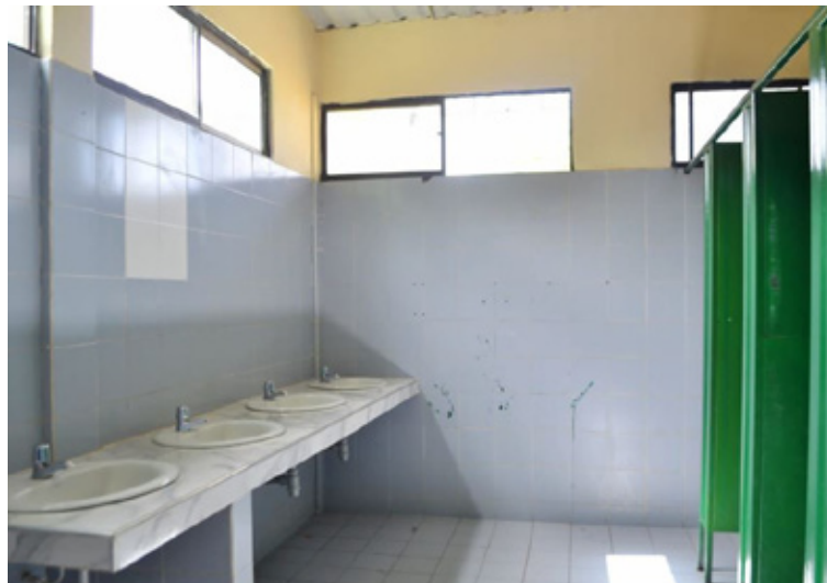
Baterías sanitarias de las instituciones educativas No. 10 sede José Domingo Boscán y No. 2 sede San Martín.
