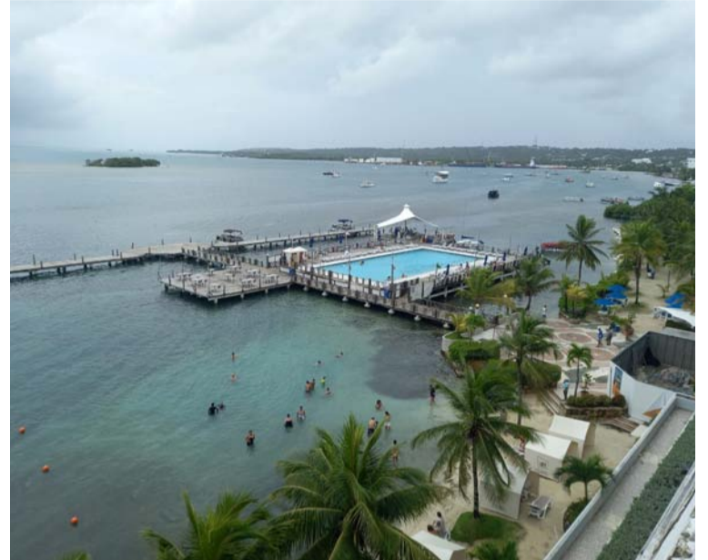
Una de las mayores preocupaciones en la isla es por el estado de la mayoría de las estructuras de las viviendas.
