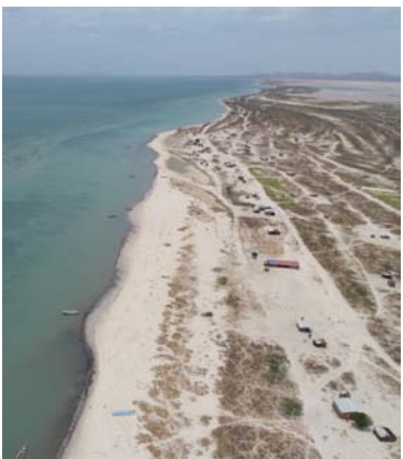
Se han ejecutado acciones para contener la erosión.
