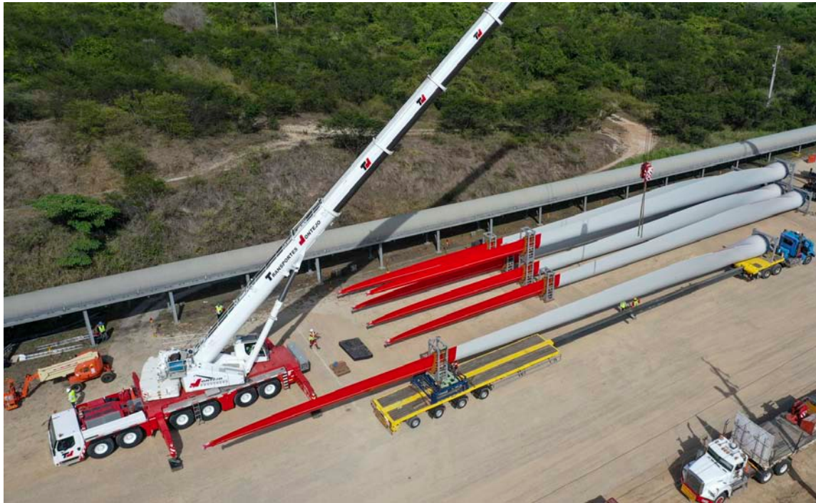
Petro mostró las aspas de un parque eólico que se instalarán en el Departamento.
