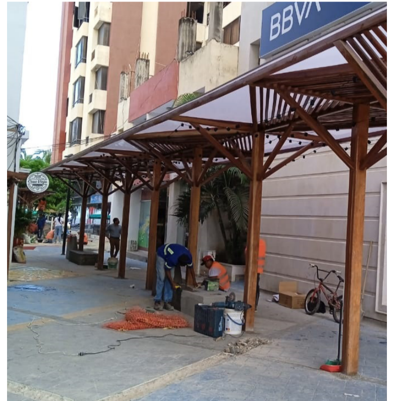
La obra tiene como novedad la instalación de una estructura de madera a lo largo de la calle y acabados en el piso.
