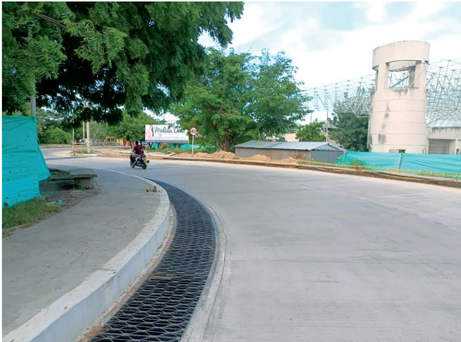
Recuperación de la Glorieta Luna Sanjuanera: Terminada al 100%.
