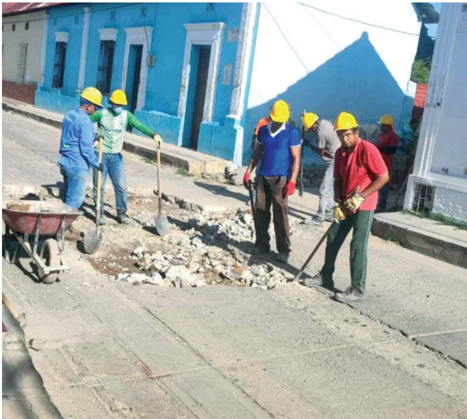
Recuperación de la malla vial y pavimentación del barrio 16 de Julio.
