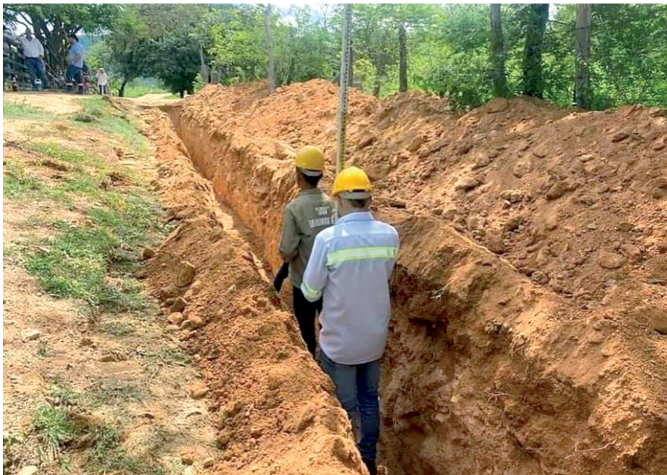
Alcantarillado Guaya canal-Corral de Piedras-Zambrano: 30%.
