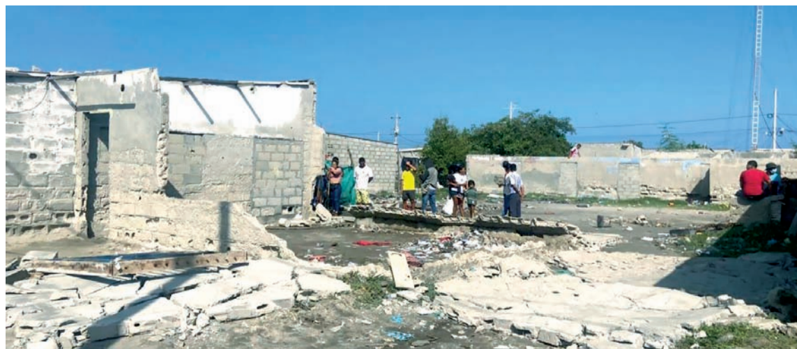
La estructura colapsó quitándoles la vida a los dos pequeños que estaban cerca.
