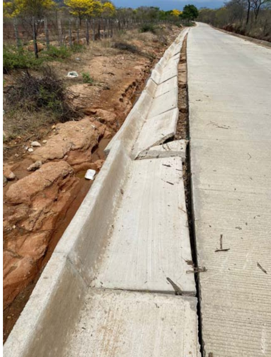
Se evaluaron los daños causados por un fuerte aguacero a 120 metros lineales de una cuneta.
