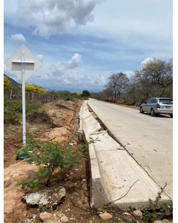
Se evaluaron los daños causados por un fuerte aguacero a 120 metros lineales de una cuneta.
