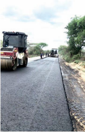
Los trabajos de pavimentación Cuestecita-La Florida.
