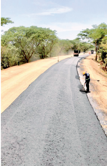
La pavimentación de vías continúa a buen ritmo.
