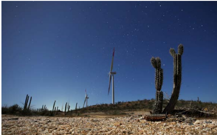
El Parque Eólico Jepirachi comenzó su operación comercial el 27 de abril de 2004, a cargo de EPM.
