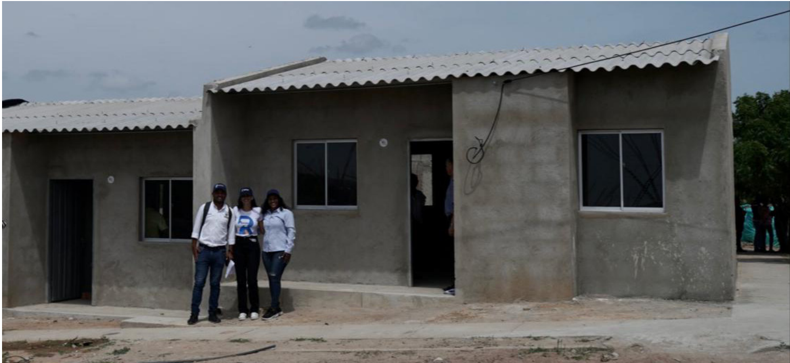
Gracias a estos esfuerzos, la Administración realizó la entrega formal de las primeras 30 casas de esta urbanización.
