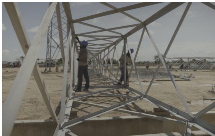
Enlaza será la encargada de construir más de 500 torres que pasan por 7 municipios en La Guajira y cuatro en el Cesar.
