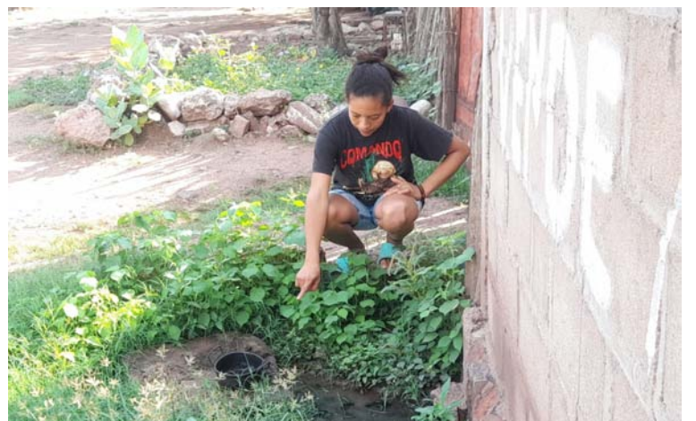
Habitantes del barrio Las Marías de Villanueva lanzan un SOS por la insalubridad que viven por el alcantarillado.
