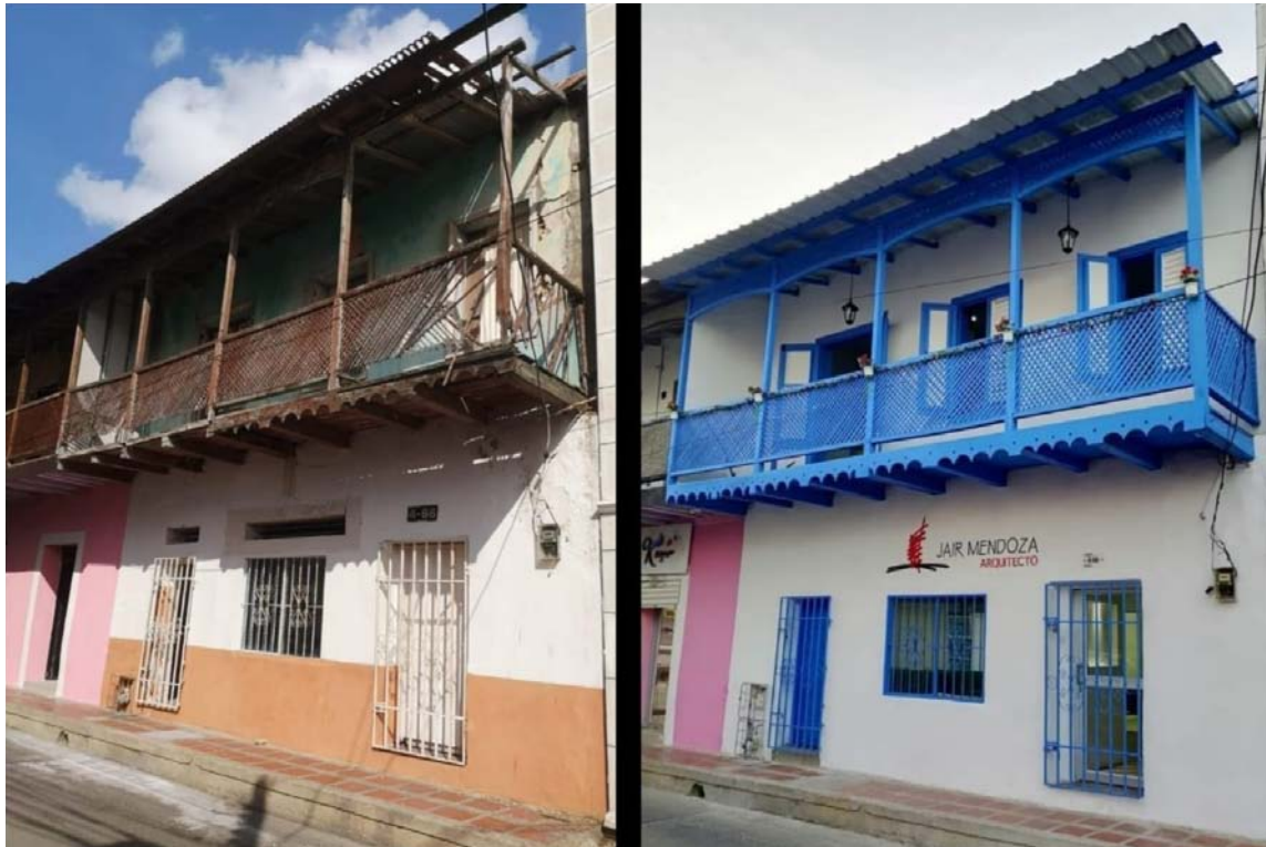
La casa Lallemand-Weber, construida hacia el año 1900, utiliza balcones de madera.
