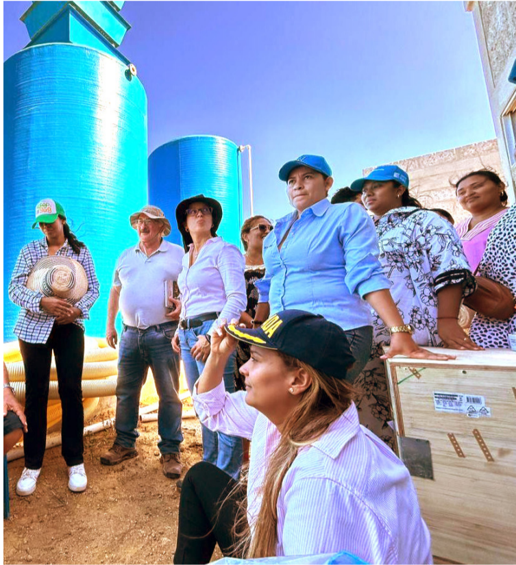
La obra del punto de producción de agua potable de Siapana, presenta un avance de ejecución del 50%.
